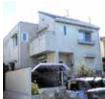
(写真上)施工後の写真 (写真下)施工前の写真
