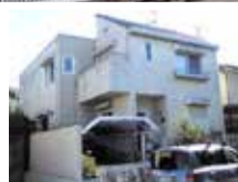
(写真上)施工後の写真 (写真下)施工前の写真
